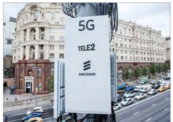
図7: 都市環境におけるエリクソン5Gマイクロ基地局 (写真: Ericsson)
